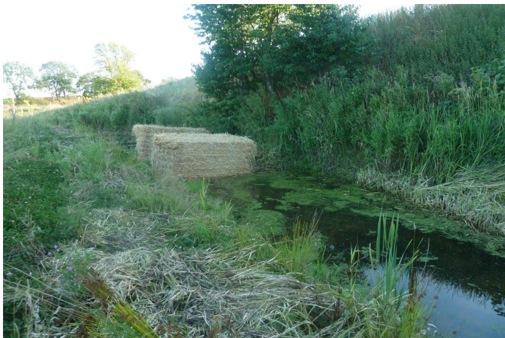
Figur 6. Utlagda halmbalar som försiktighetsåtgärd nedströms rensning av sedimentfälla.
