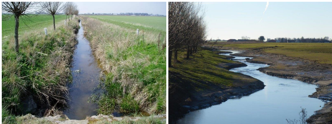
Figur 4. Åsträcka före (vänster) och efter (höger) omgrävning och etablering av vattendragsområde
